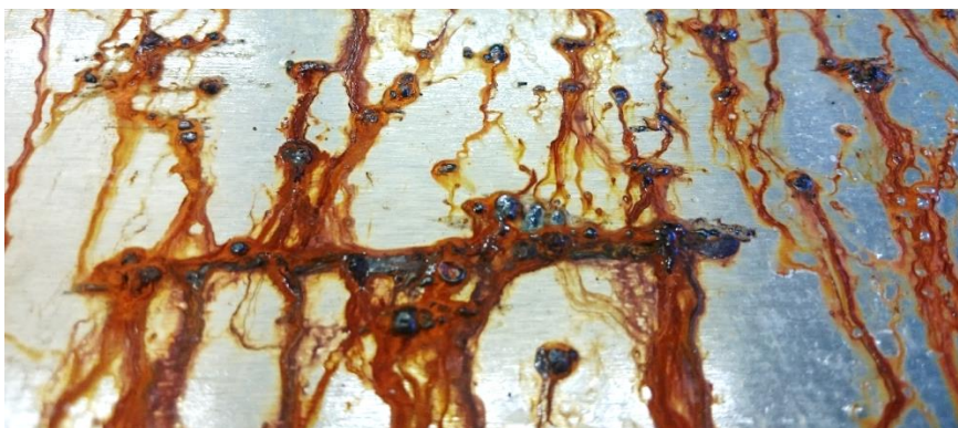
Slika 36. Korozija uzorka 2 nakon 29 dana u slanoj komori
