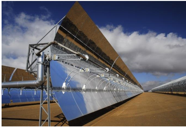
Slika 10. Tipični linearni parabolički kolektor [9]
