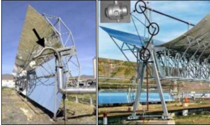
Slika 11. Prikaz fleksibilne cijevi i kuglastog zgloba [10]
