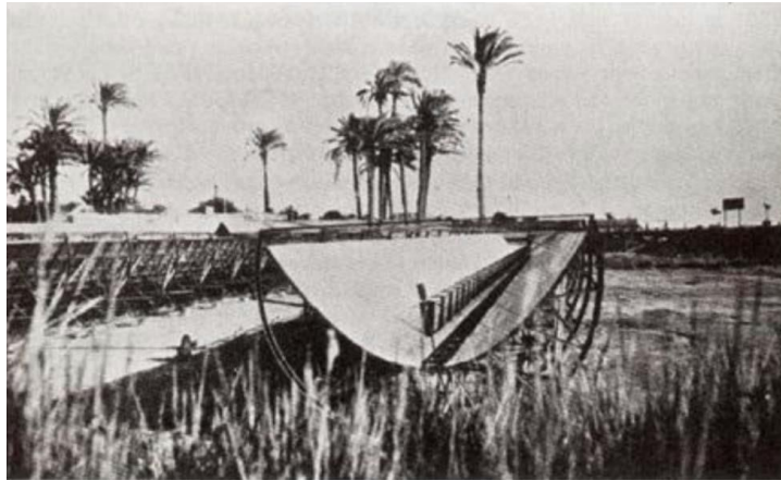
Slika 8. Shumanov solarni parabolički kolektor [7]
