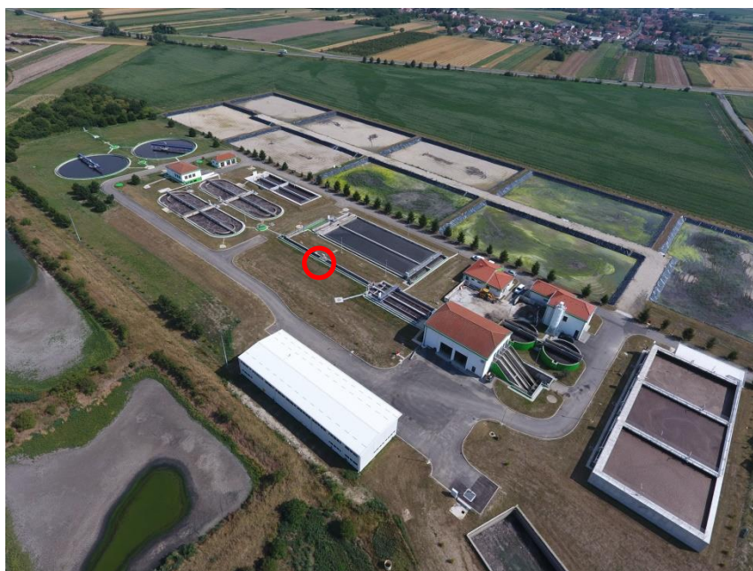
Slika 7. Pročištač otpadnih voda aglomeracije Čakovec
