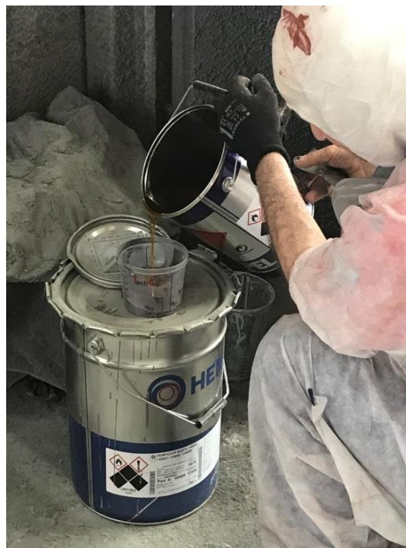
*Slika 24. Priprema dvokomponentnog premaza*
