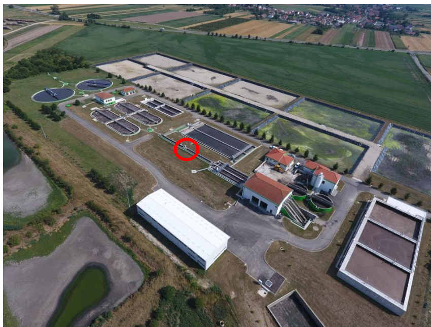
Slika 3.1. Pročistač otpadnih voda aglomeracije Čakovec
