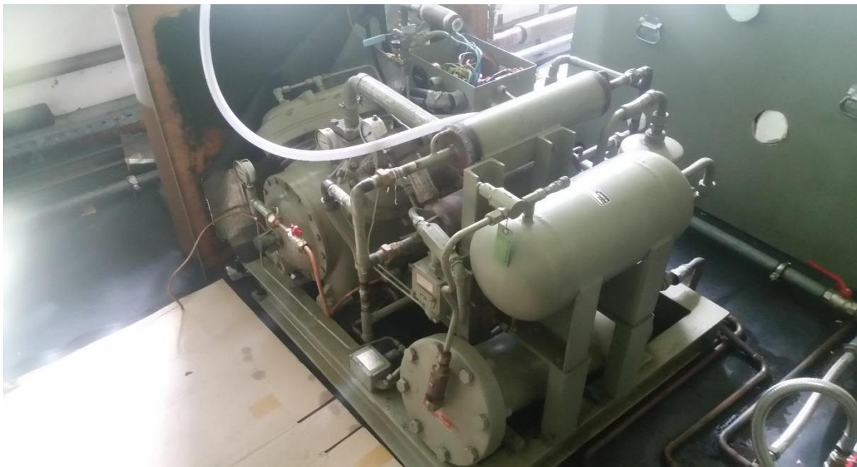
Slika 20. Klipni kompresori ( zvučna izolacija – iza )
