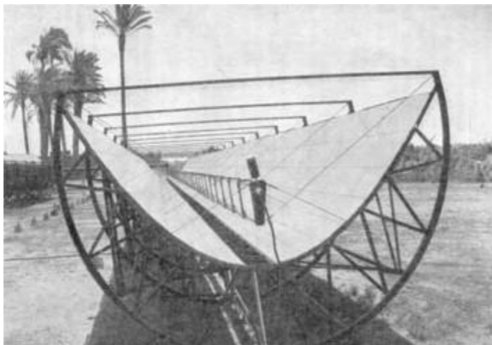
Slika 2. Parabolični kolektori primijenjeni u Egiptu, izgrađeni 1913. godine [3].
