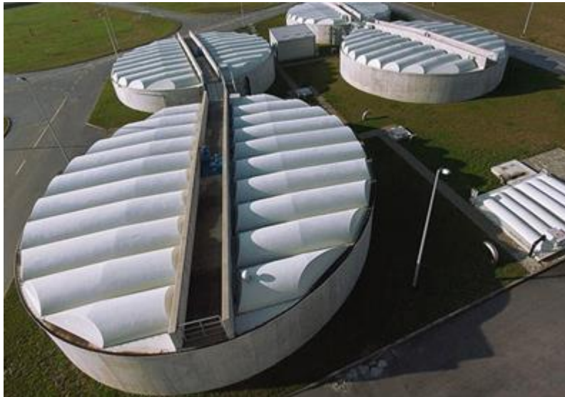
Slika 2.13. Prethodni i naknadni gravitacijski zgušnjivači na CUPOVZ.
