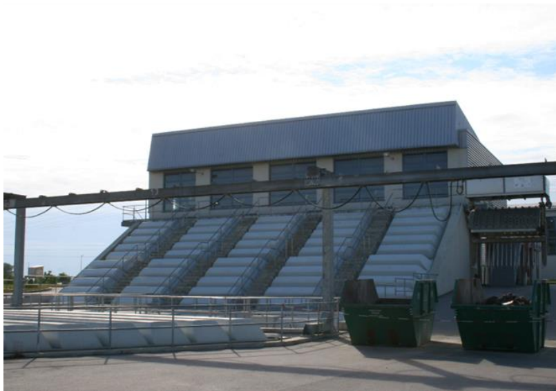
Slika 2.7. Ulazna crpna stanica na CUPOVZ.
