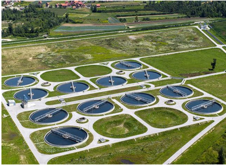
Slika 2.12. Naknadni taložnici na CUPOVZ.
