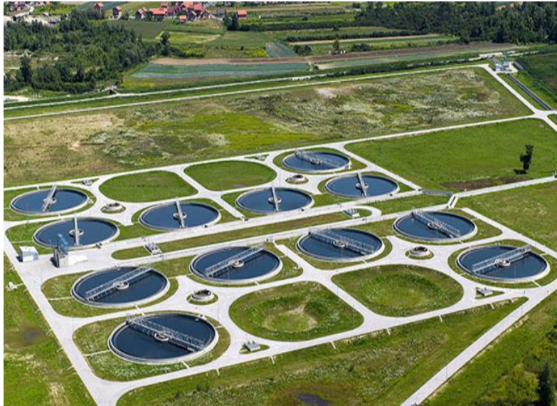
Slika 2.12. Naknadni taložnici na CUPOVZ.
