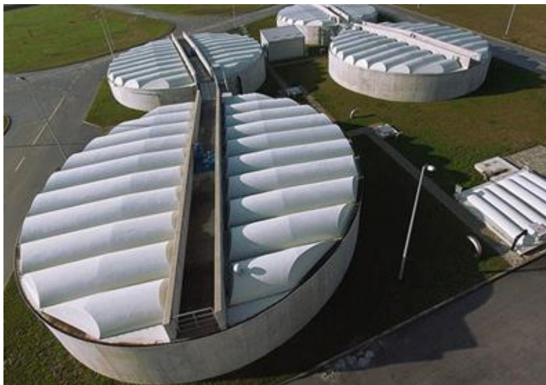
Slika 2.13. Prethodni i naknadni gravitacijski zgušnjivači na CUPOVZ.
