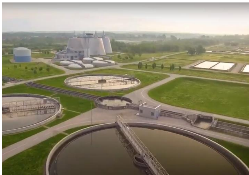
Slika 2.5. Centralni uređaj za pročišćavanje otpadnih voda grada Zagreba, CUPOVZ.
