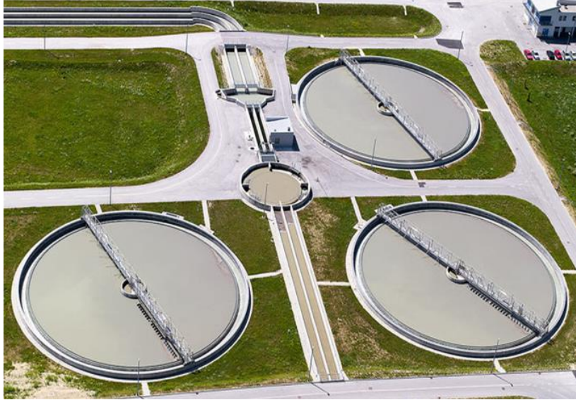
Slika 2.10. Prethodni taložnici na CUPOVZ.
