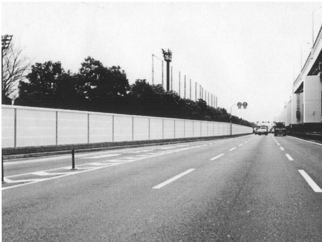
Slika 15. Zvukobran u Japanu prekriven slojem  $TiO_2$  fotokatalizatora u svrhu otklanjanja  $NO_x$  spojeva [36].
