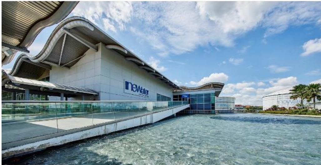
Slika 2.9. Postrojenje za oporabu KOV u Singapuru 40
