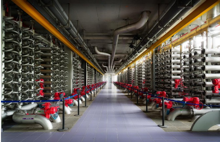
Slika 2.6. Méry-sur-Oise postrojenje za pripremu pitke vode korištenjem nanofiltracije 19
