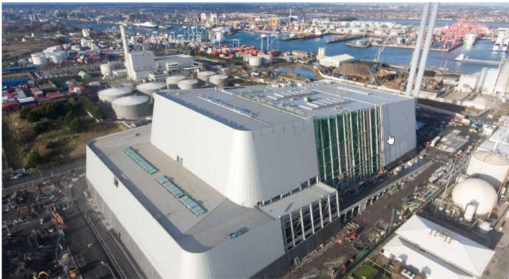
Slika 9. Postrojenje za zbrinjavanje otpada u Dublinu [9]
