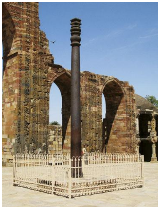
Slika 2. Prikaz nekorodirajućeg željeznog stupa u Delhiju 5
