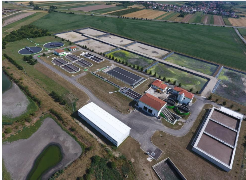
Slika 3.1 . Pročistač otpadnih voda aglomeracije Čakovec
