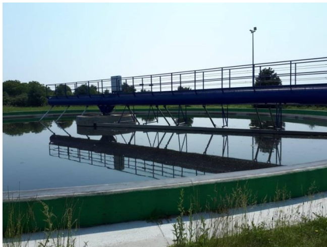
Slika 2. Sekundarni taložnik
