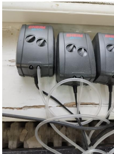
Slika 12. Aeracijske pumpe Eheim air400, Njemačka
