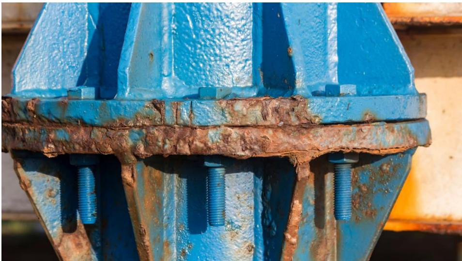
Slika 7 Premaz pod utjecajem korozije [14]
