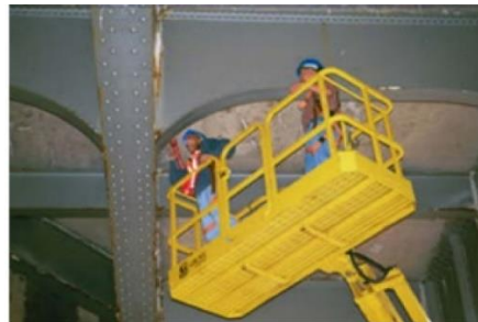
Slika 13. Teškoće kod izvođenja vizualnog pregleda čeličnog mosta: a) slabo osvjetljenje, b) rad na visini [28]
