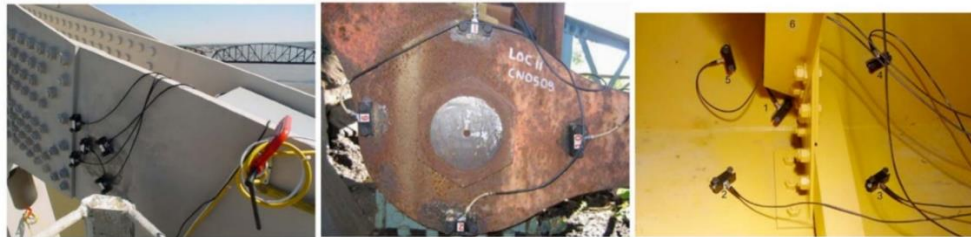
Slika 20. Primjena metode akustične emisije kod inspekcije čeličnih mostova [28]
