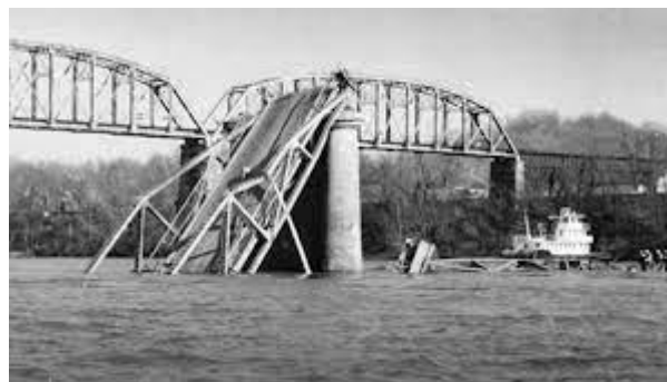
Slika 1. Rušenje mosta preko rijeke Ohio 1967. godine kao posljedica korozije [5]
