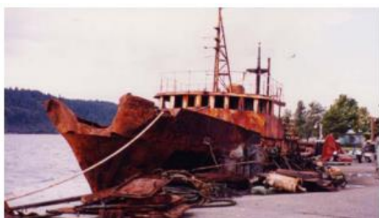
Slika 2. Brod zahvaćen korozijom [8]
