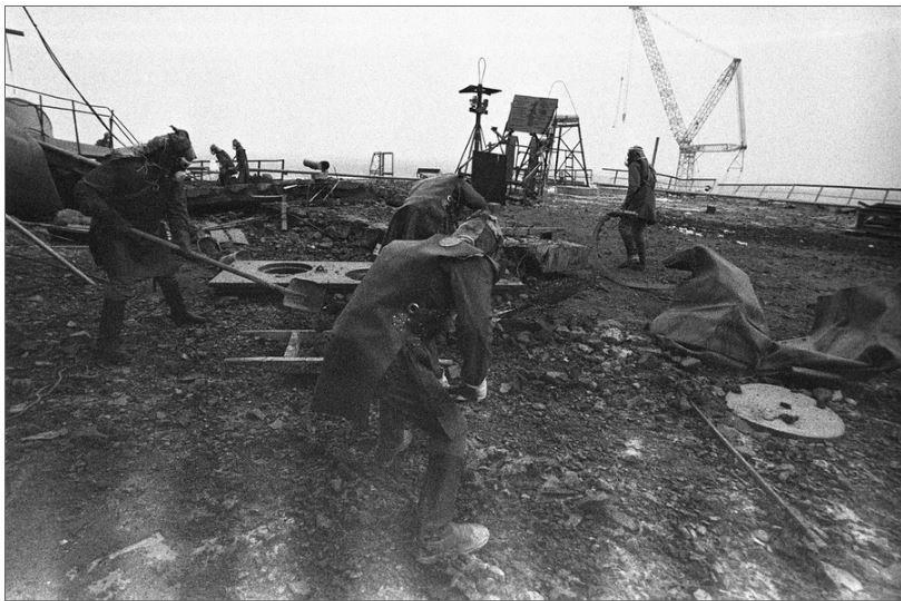
Slika 11. Likvidatori bacaju grafit natrag u jezgru uništenog reaktora koja će kasnije biti prekrivena sarkofagom [14].
