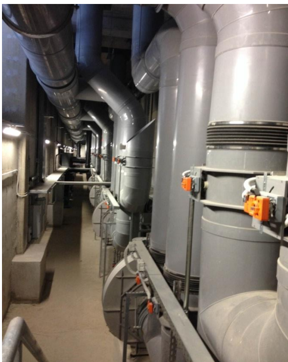
Slika 29. Prikaz cijevi za upuhivanje zraka za biosušenje
