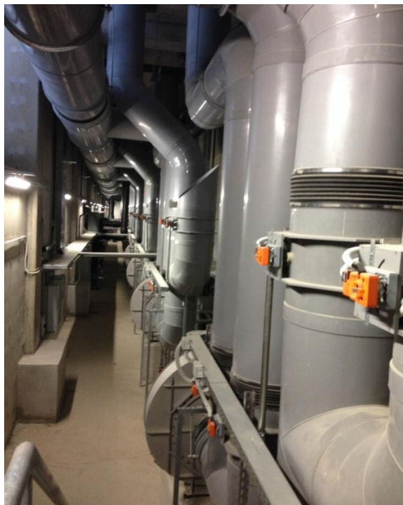
Slika 29. Prikaz cijevi za upuhivanje zraka za biosušenje
