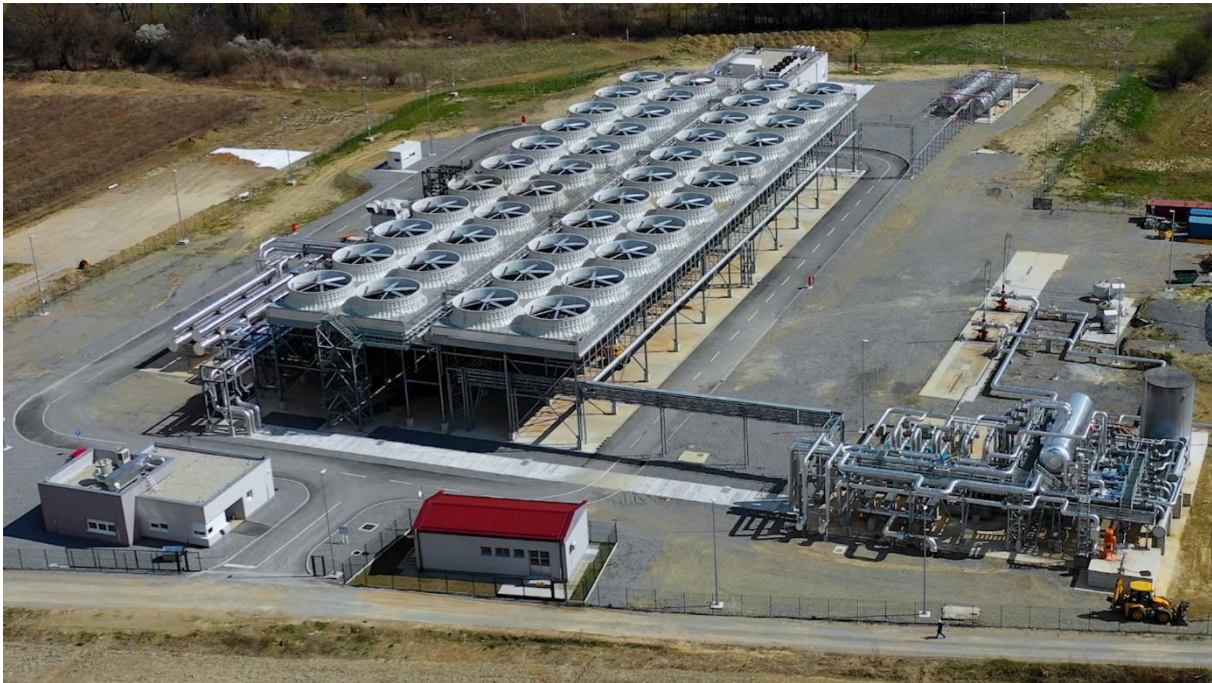
Slika 14. Geotermalna elektrana Velika 1 [21]
