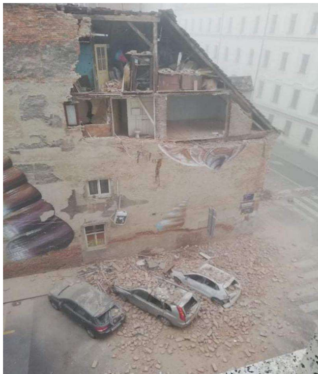
Slika 22. Zgrada zidana od opeke s drvenom međukatnom konstrukcijom [33]
