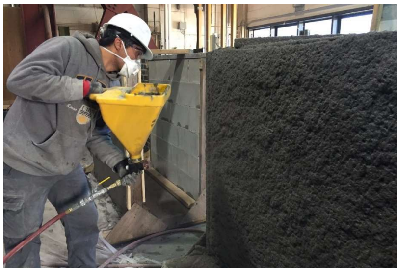
Slika 10. Nanošenje betona otpornog na potrese na već postojeći zid [18]
