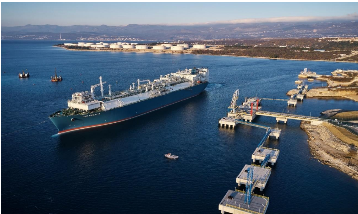
Slika 6. LNG terminal Omišalj-Krk
