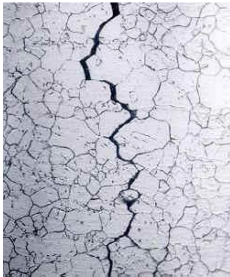
Slika 7. Primjer napetosne korozije [13]
