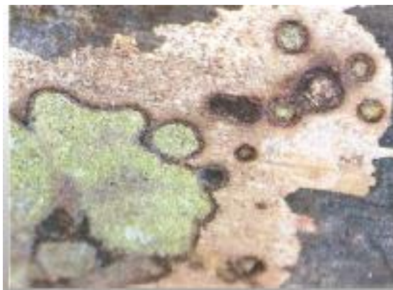
Slika 9. Izgled mikrobiološke korozije [9]
