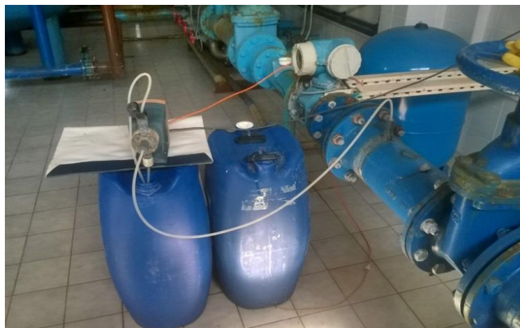
Slika 8. Improvizirani način doziranja dezinfekcijskog sredstva (NaOCl)
