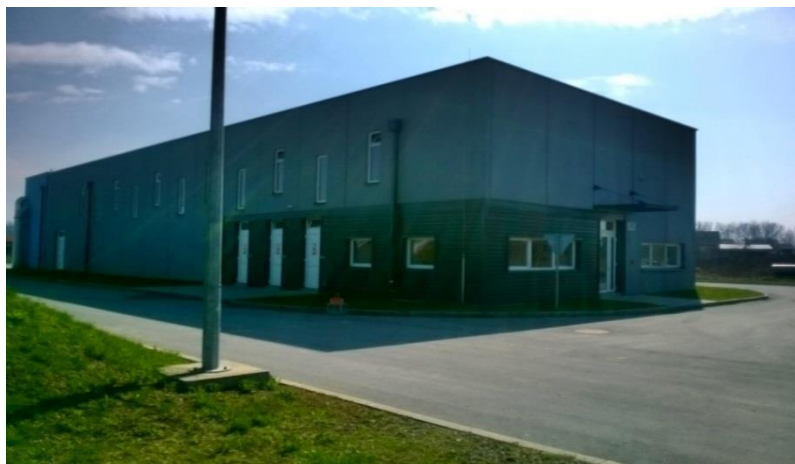
Slika 12. Vodovod u Brodsko-posavskoj županiji
