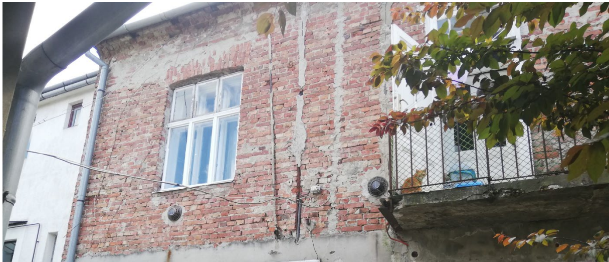
Slika 3B. Vanjska fasada sjever – dvorišna strana (istočni dio)
