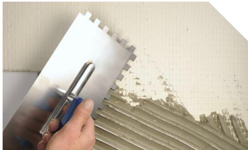
**Slika 24.** Mortovi za lijepljenje pločica [25]
