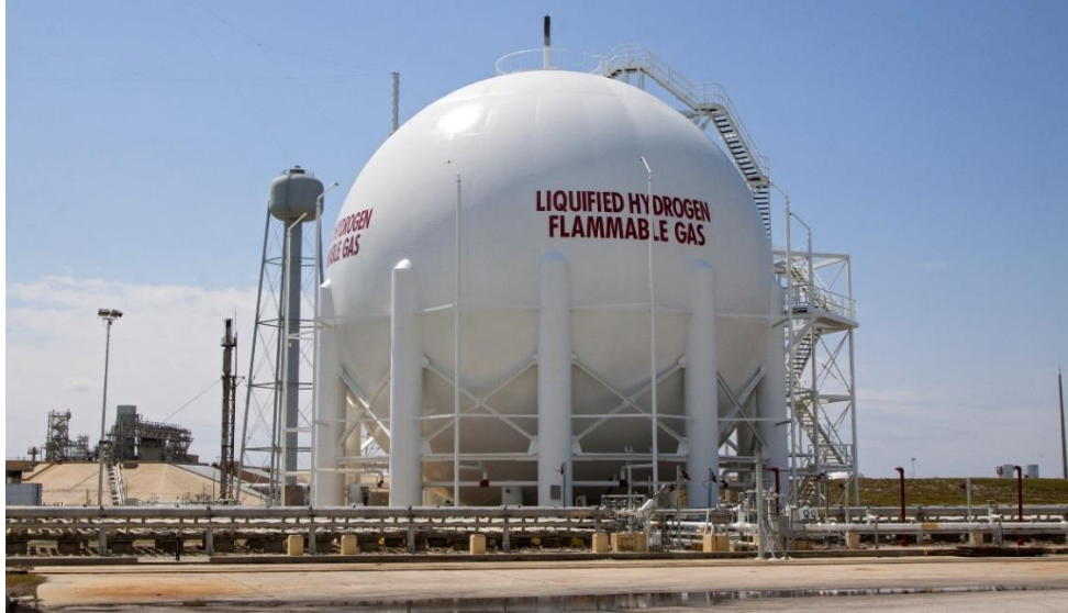
Slika 4. Spremnik tekućeg vodika [23]
