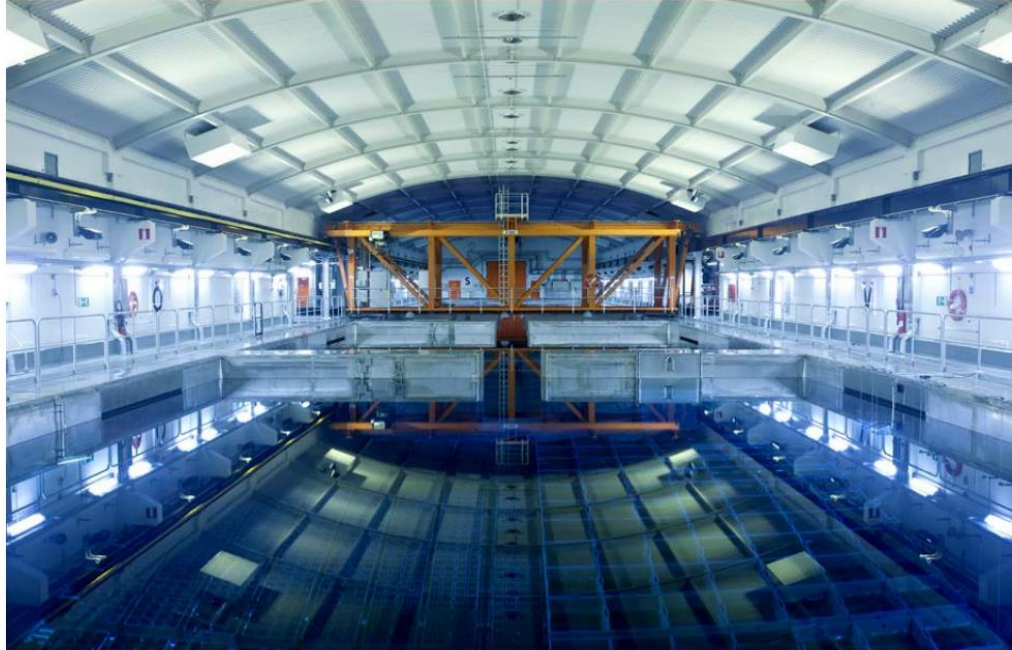
Slika 3.4. Mokro skladište istrošenog nuklearnog goriva u Švedskoj. [6]
