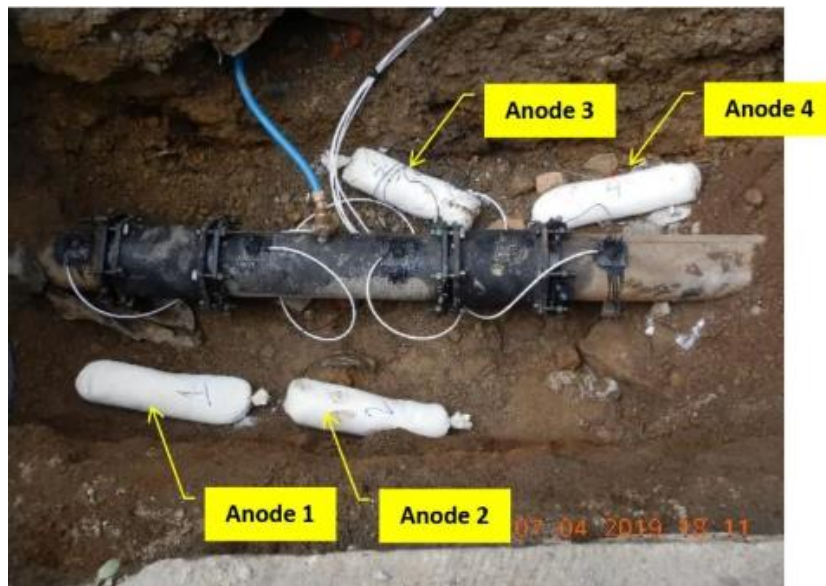
Slika 8. Prikaz katodne zaštite[28]
