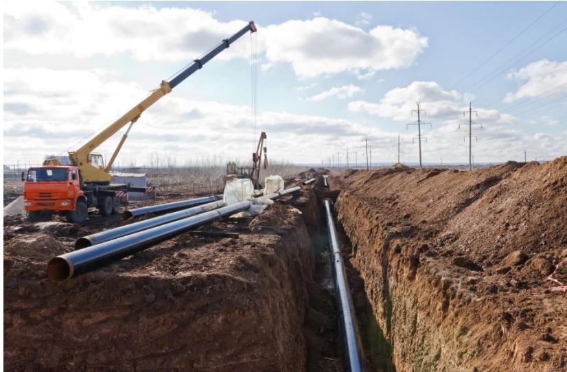
Slika 17. Metoda otvorenog rova[33]
