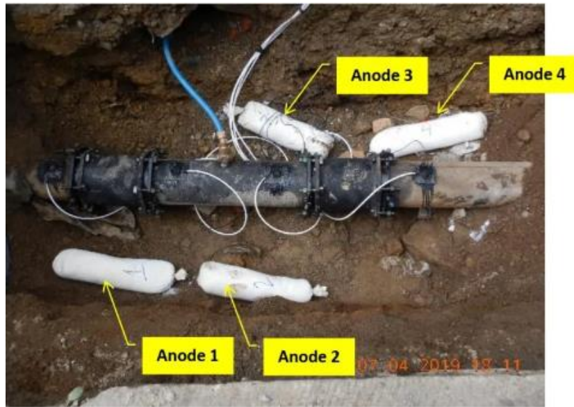
Slika 8. Prikaz katodne zaštite[28]
