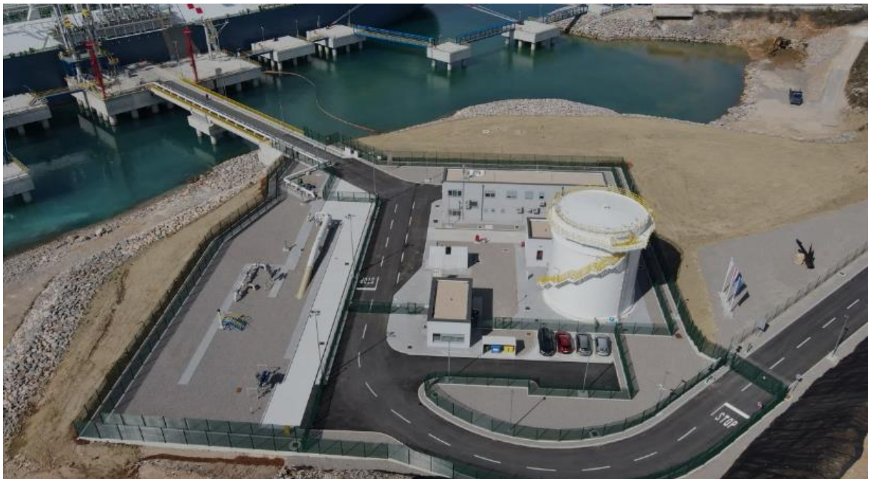
Slika 3. Kopneni dio LNG terminala [6]
