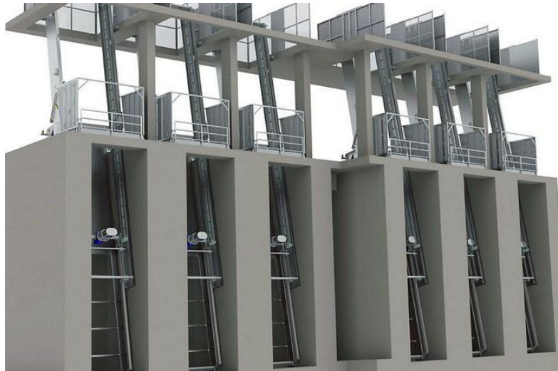
Slika 2.4. Komora za pijesak
