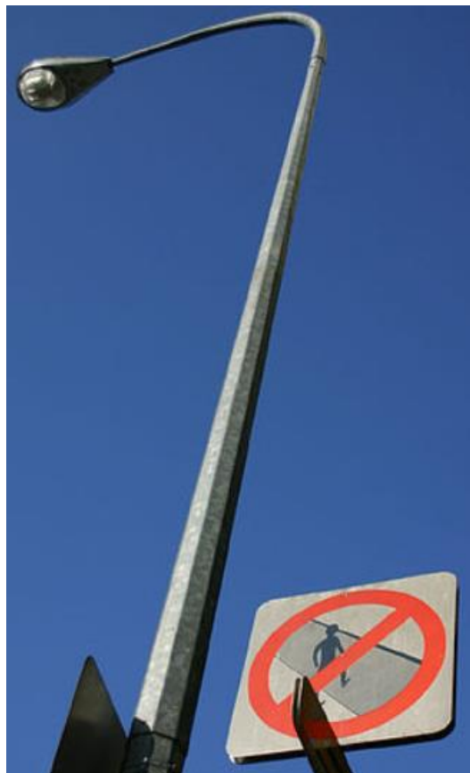
Slika 5. Stup javne rasvjete podvrgnut galvanizaciji cinkom 12
