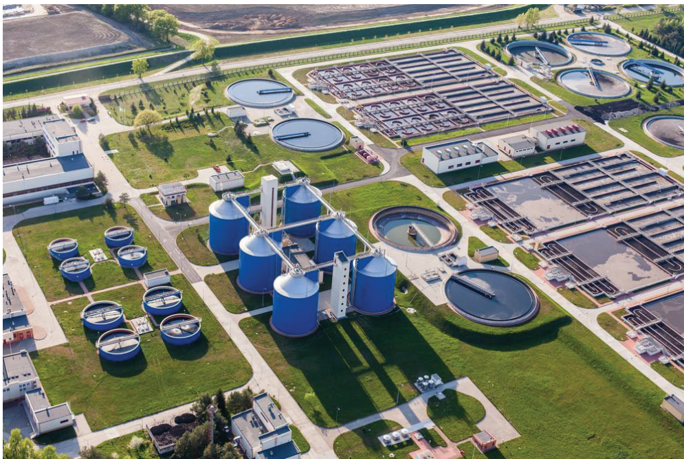
Slika 6. Postrojenje za obradu otpadnih voda [12]
