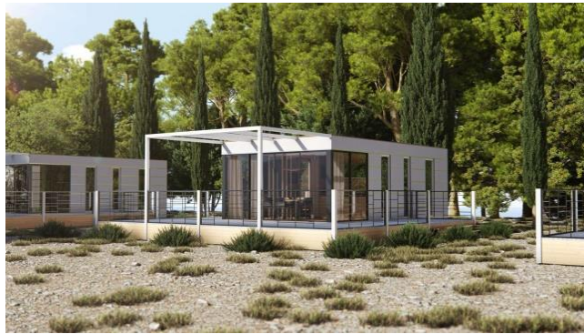
Slika 3. Montažna kuća u kampu većinski izrađena od kompozitnih materijala [7]
