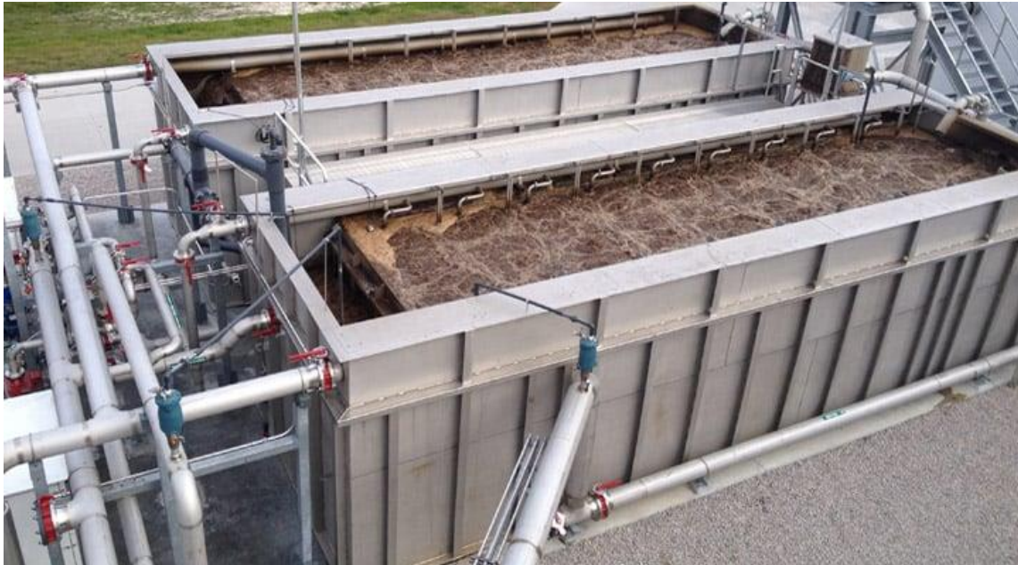
Slika 15. Membranski bioreaktor tvrtke ADI Systems
