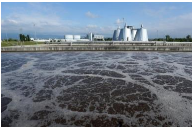
Slika 6. Prikaz aeriranog bazena s aktivnim muljem u Zagrebu [26]
