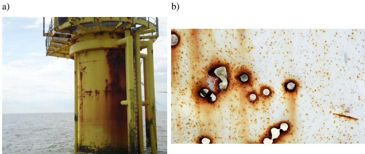
Slika 7. Primjer a) jednolike korozije [18] i b) jamičaste korozije odobalne vjetroelektrane [17]
