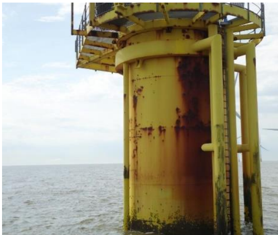
Slika 7. Primjer a) jednolike korozije [18] i b) jamičaste korozija odobalne vjetroelektrane [17]
