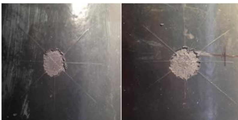
Slika 4.18. Test na katodno odvajanje oštećenja promjera 6,5 mm i 13 mm za sustav S3 u atmosferskoj zoni
