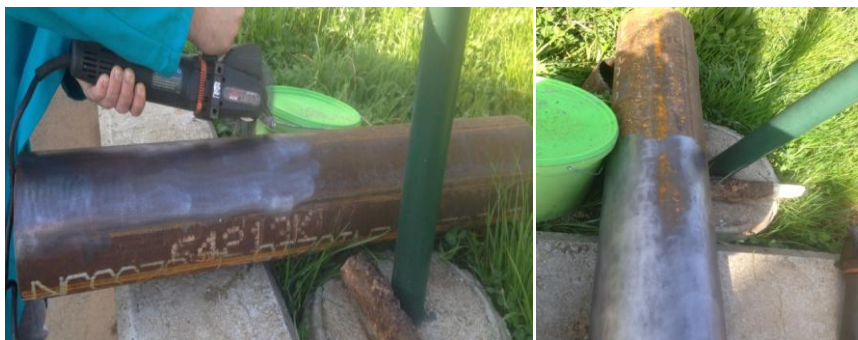
Slika 3.2. Predobrada površine rotacijskom četkom
