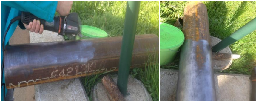
Slika 3.2. Predobrada površine rotacijskom četkom
