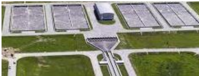
Slika 4. Bazeni za biološku obradu otpadnih voda na Zagrebačkim otpadnim vodama
