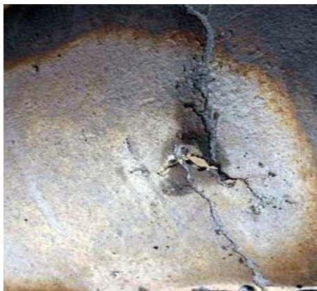
Slika 14.: Oštećenja metala nastala uslijed sulfidnog naprezanja [19]
