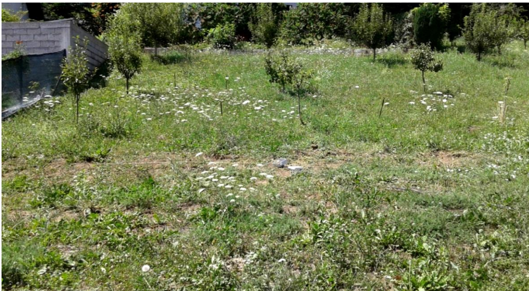
Slika 29. Teren ukopa četiri pojedinačna vertikalna anodna ležišta
