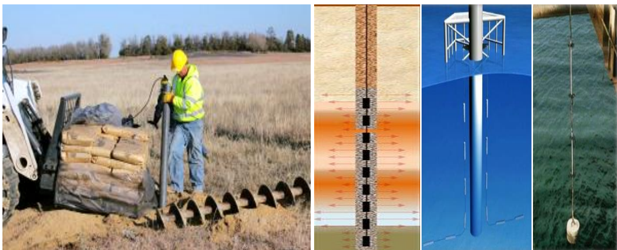
Slika 13. Duboko anodno ležište s koksnim punilom u tlu [19,20] i bez punila u moru [21]
