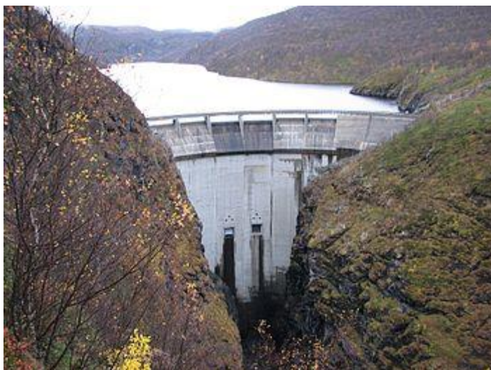
Slika 2.14. HE u Alti, Norveška. Primjer korištenja reljefa za osiguravanje spremnika vode. ( https://en.wikipedia.org/wiki/Electricity_sector_in_Norway pristupio 10.5.2017)
